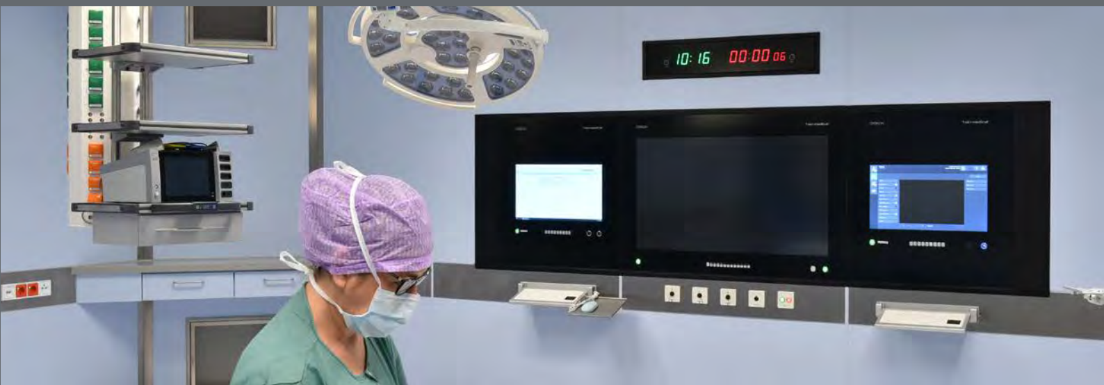
Maßgeschneidertes Sondergehäuse für zwei OPERION 24" und OPERION 46", Add On: Anschlussfelder, DOCTRAY und 890 mm INFOBAR, Klinikum Weilheim-Schongau
